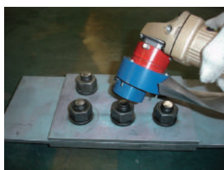
ボルトに飛散防止カバーをかぶせます
