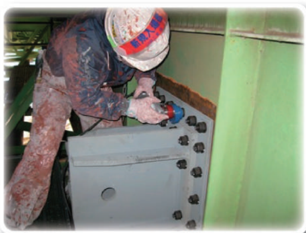
大渡橋補修工事におけるEZクリーナー使用状況
