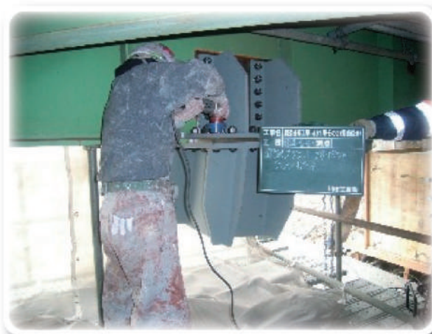
大渡橋補修工事におけるEZクリーナー使用状況
