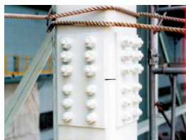
柱+柱のジョイント
