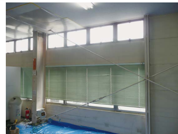
T工場食堂耐震
