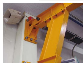
ジブクレーン取付
