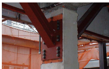
RC柱 鋼板巻耐震工事
