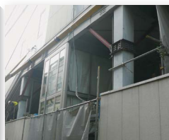
エレベーター設置 補強
