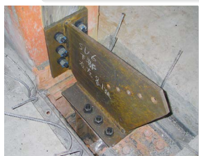
病院耐震増築工事
