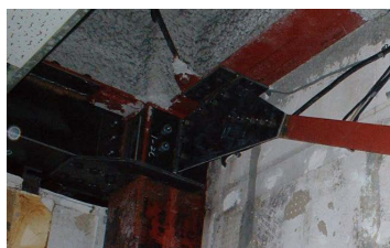
斜材取付・ブレースPL取付
