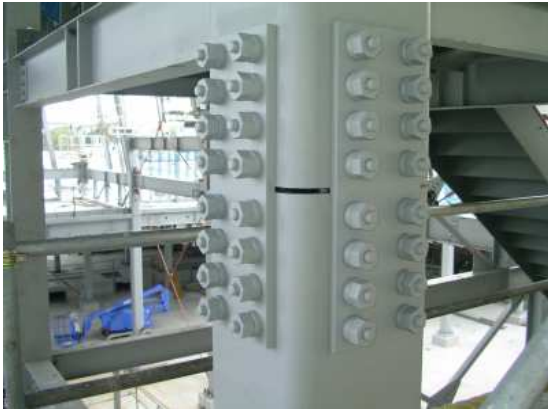
写真-9 角形鋼管柱継手
