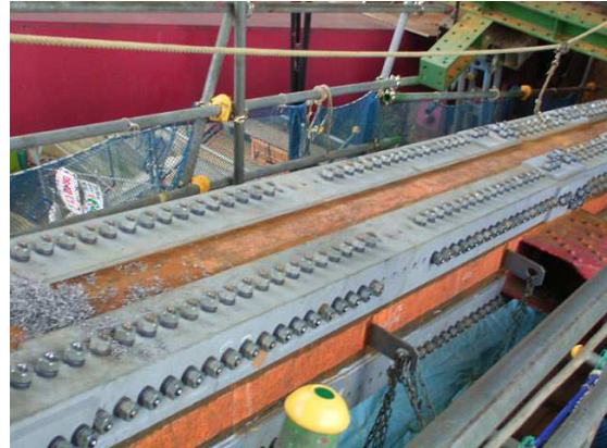
写真-11 鋼アーチ橋補強
