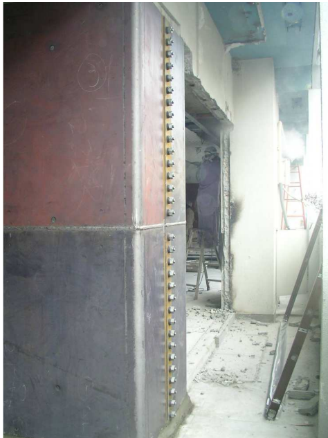
写真-10 RC柱鋼板巻き補強
