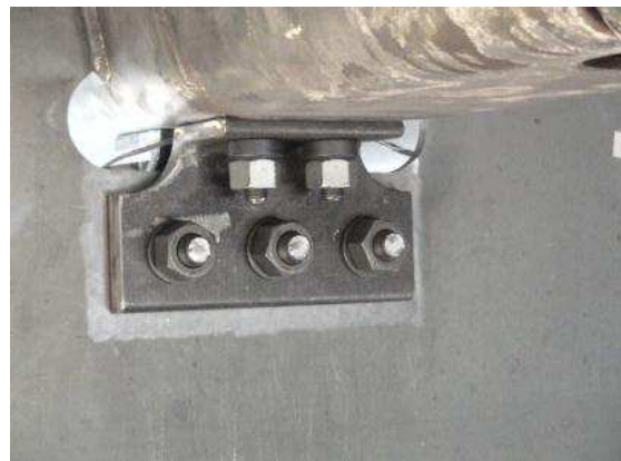
写真-12 鋼床版Uリブ補強
