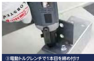
③電動トルクレンチで1本目を締め付け
