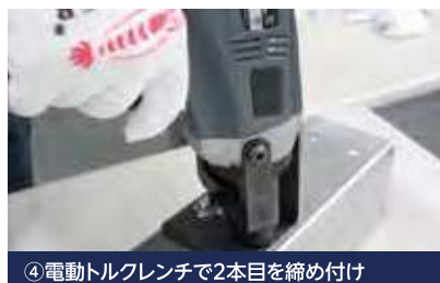
④電動トルクレンチで2本目を締め付け
