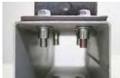
③電動トルクレンチで1本目を締め付け
