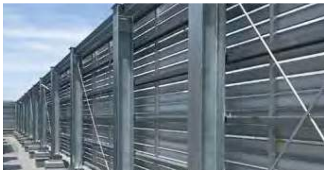
目隠しルーバー下地 | 長野県
