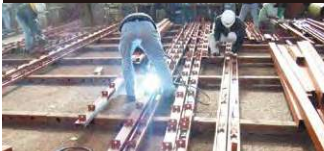
一般胴縁の場合 溶接作業
