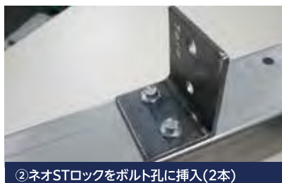
②ネオSTロックをボルト孔に挿入(2本)
