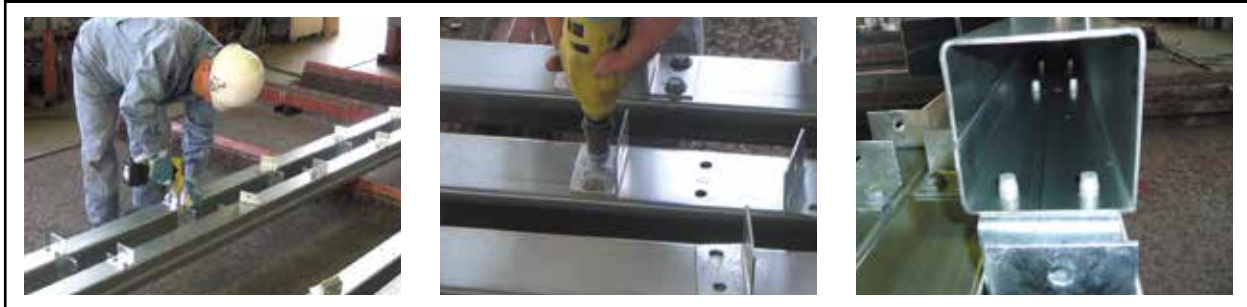
開発技術「エコザック」のネコピース取付作業状況
