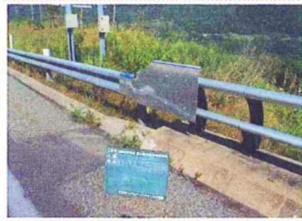
ロブテックスファスニングシステムは「摩擦型特殊ドリルとタッピング型ワンサイドボルト」を用いた新たな締結工法を開発。橋梁検査路や遮音壁などの付属物などでボルトナット接合もしくは裏ナット溶接部位などに有効な工法として、今後業務を強化していく。
